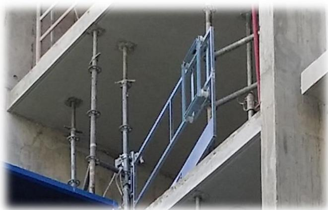
PORTE PALIÈRE COULISSANTE AVEC SYSTÈME DE VERROUILLAGE.
